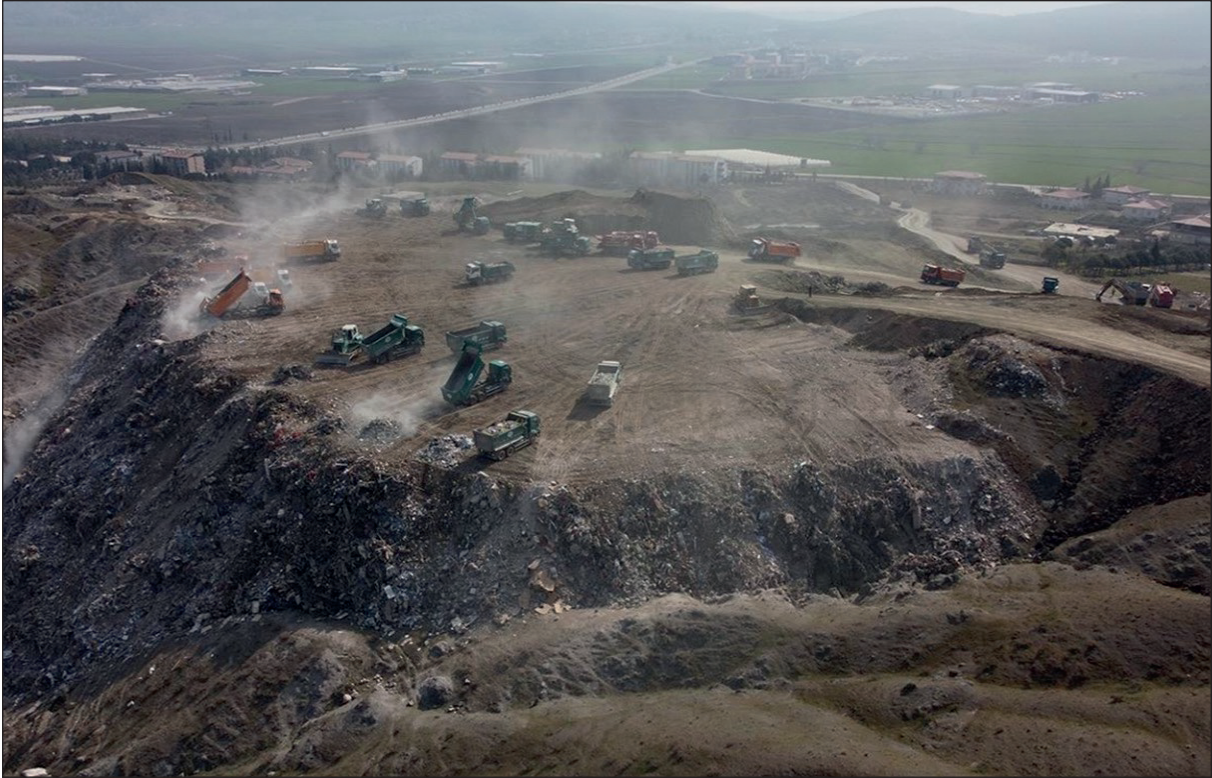
Resim 1. Şubat 2023 Kahramanmaraş depremi sonrası yıkılmış binaların molozlarının istiflenmesi esnasında oluşan hava kirliliği.
